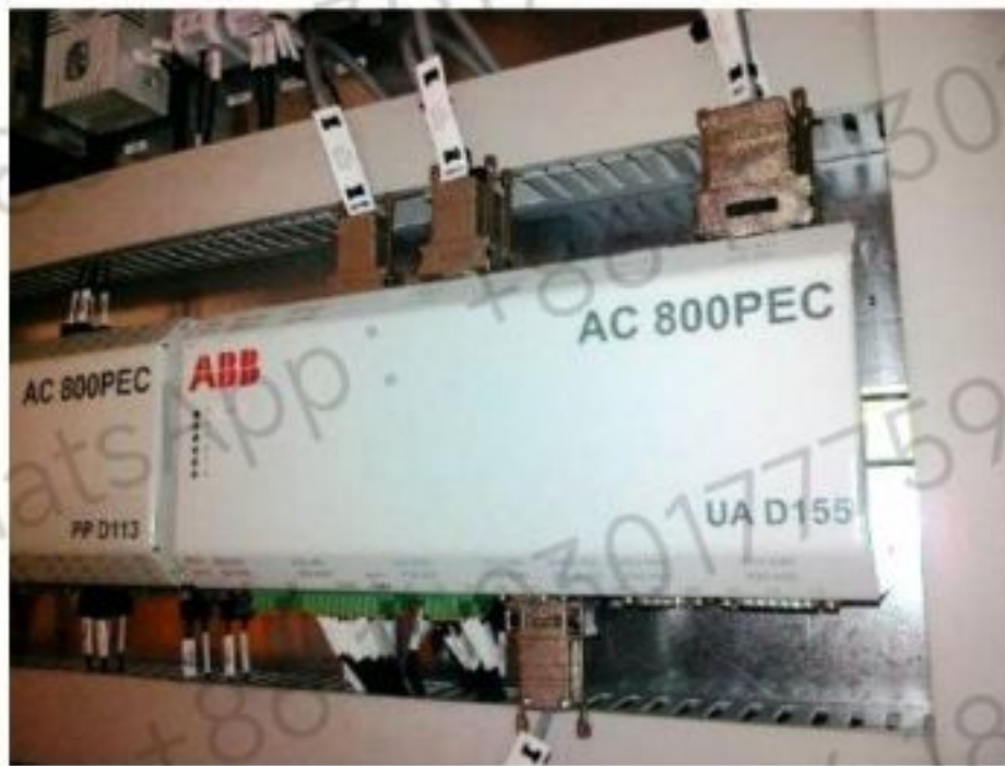
Figure 8-4 AC 800PEC Combi IO UA D155
