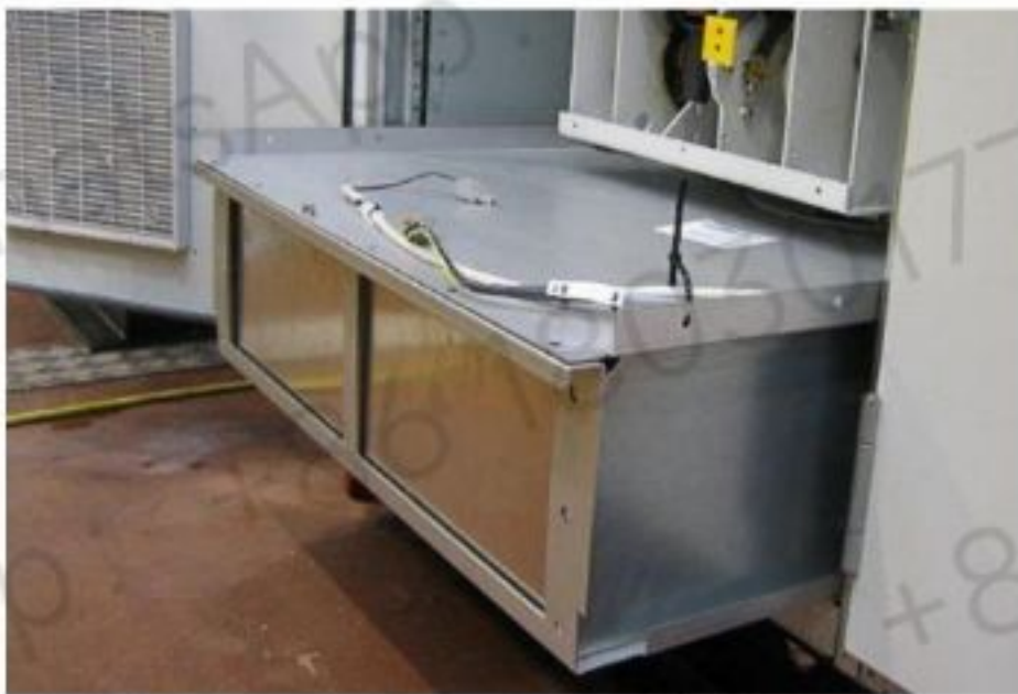
Figure 10–136 Fan drawer below the GEB
