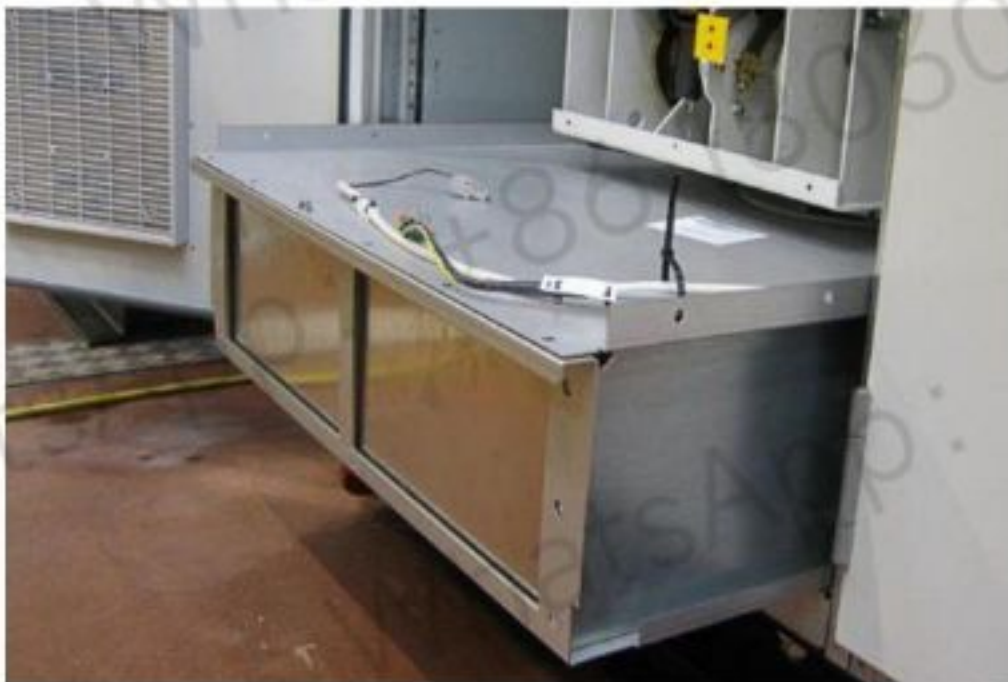
Figure 10-111 Fan drawer below the GEB
